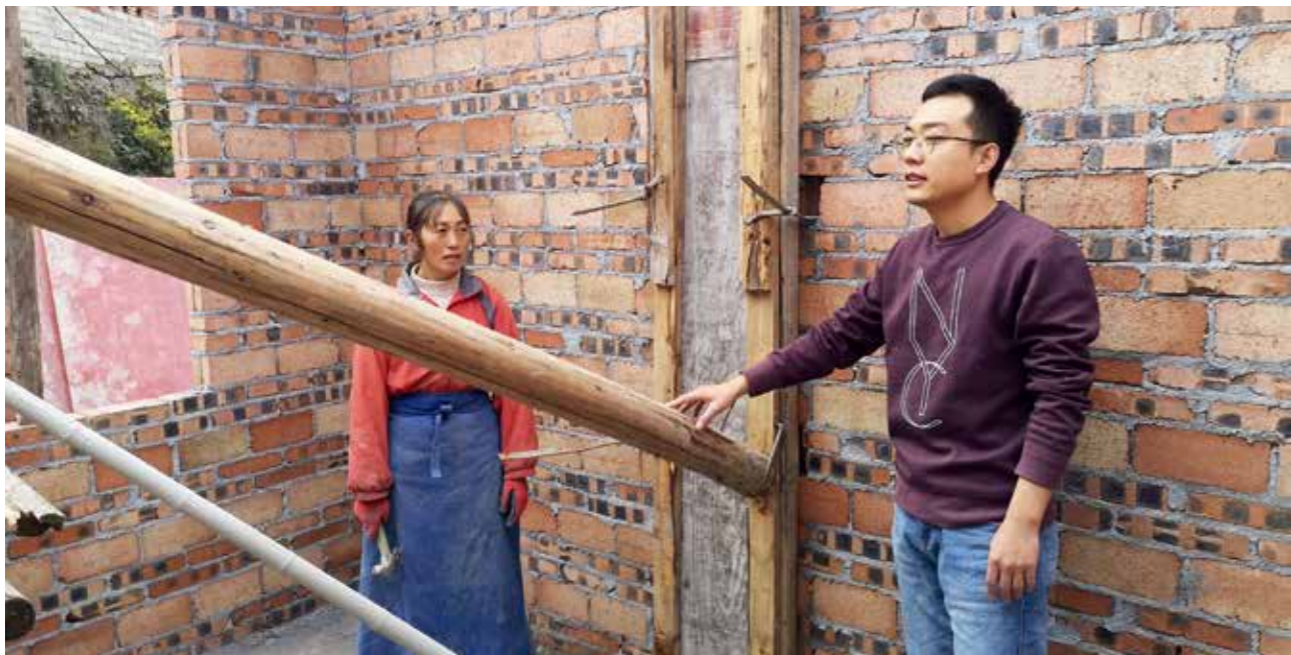
查看安全房建设情况
