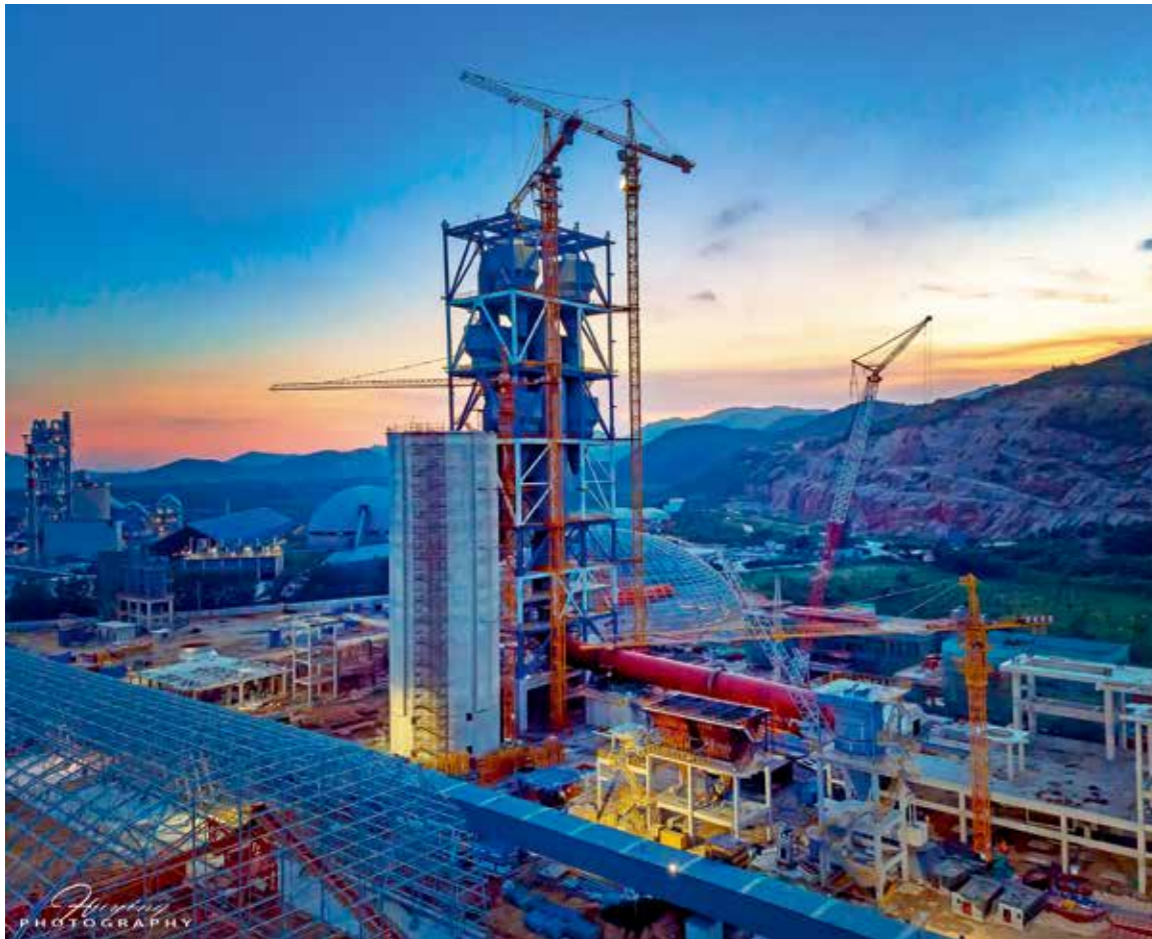
建设中的湖州槐坎南方水泥
