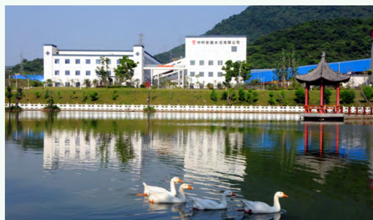
中材安徽水泥有限公司水泥窑无害化协同处置—巢湖市日处理500吨生活垃圾项目
